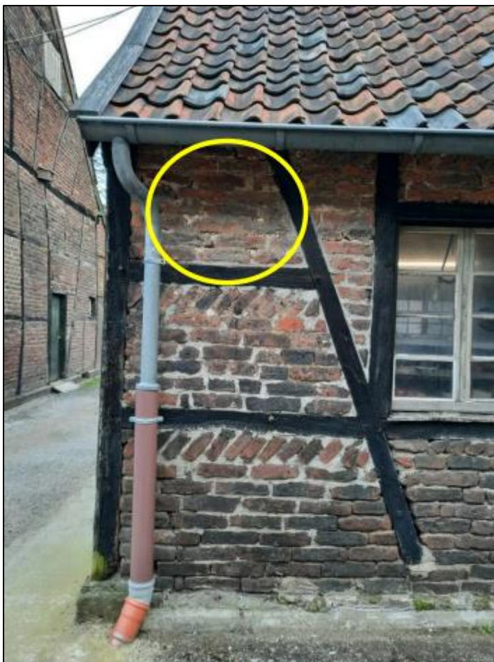
Abbildung 37: Westliche Gebäudewand des Werkstattgebäudes mit einer Fortpflanzungsstätte von Wildbienen an einer witterungsgeschützten Stelle.
