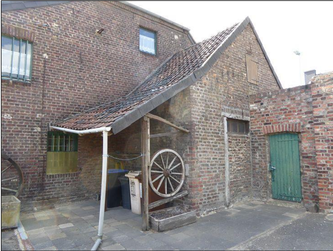
Abbildung 15: Alte Gebäudestruktur vom Hof aus an der Uerdinger Straße.
