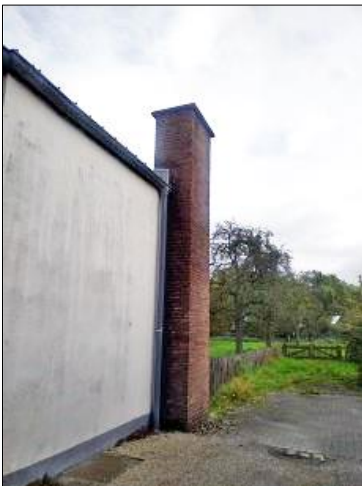
Abbildung 6: Schornstein aus Backstein an dem Gebäude des Autohauses.
