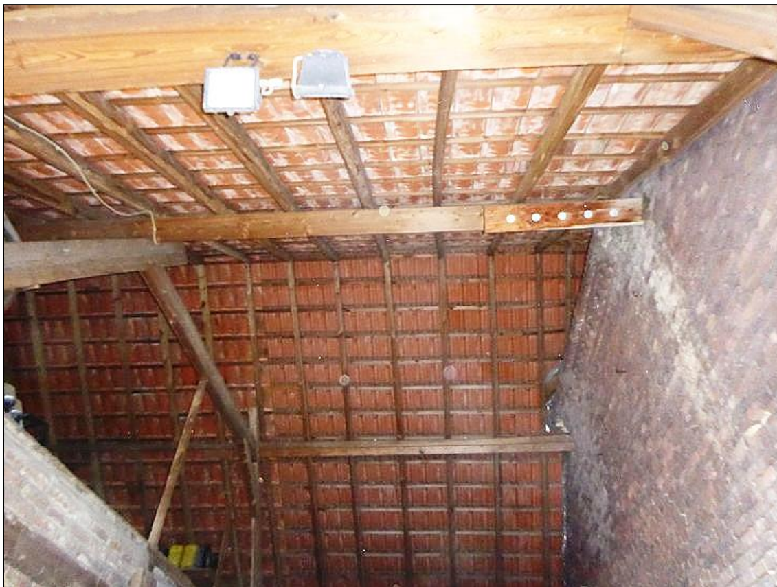
Abbildung 19: Teils ist das Scheunendach aber noch ursprünglich gedeckt mit nackten Ziegeln auf Holzbalken.
