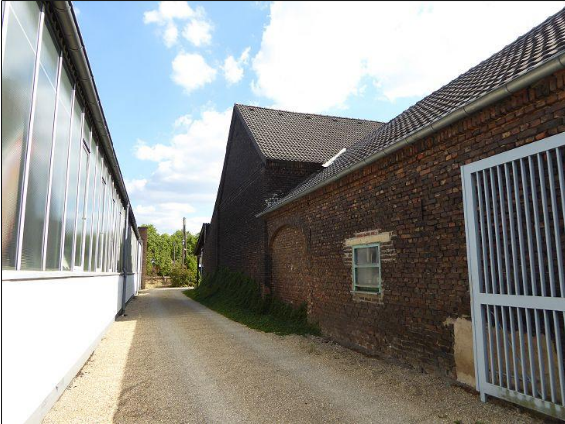
Abbildung 21: Zufahrt zum Wohnhaus der Familie Kothen. Rechts: die große Scheune, links: Gebäude des Autohauses.
