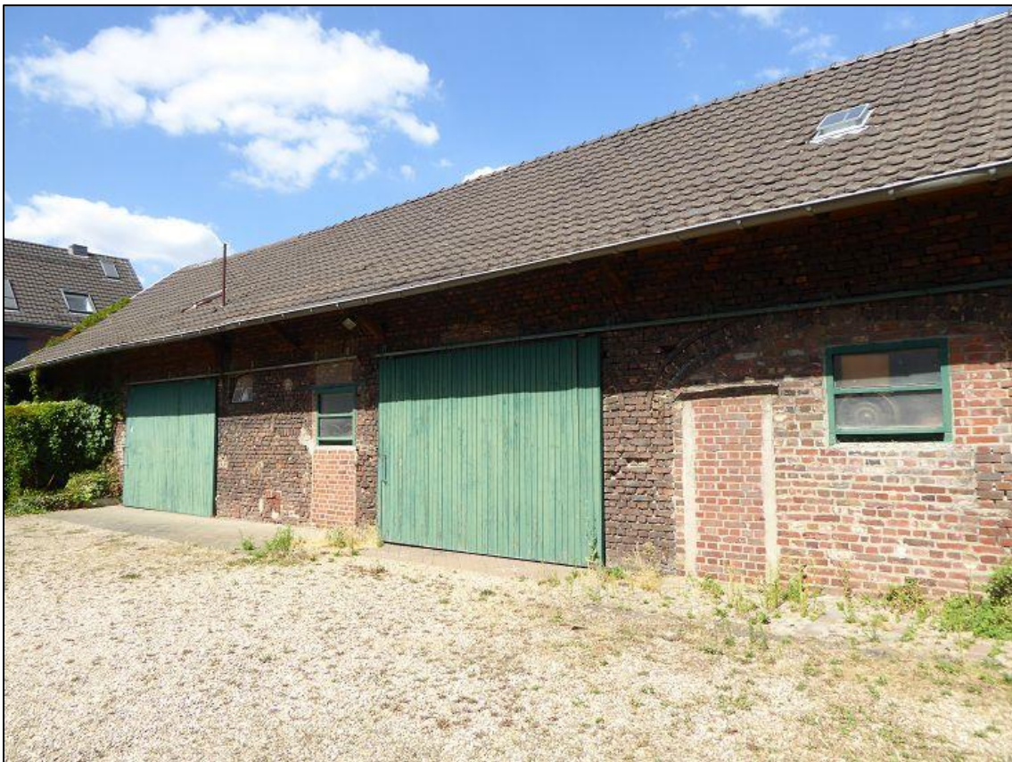
Abbildung 16: Alte Scheunengebäude von außen.
