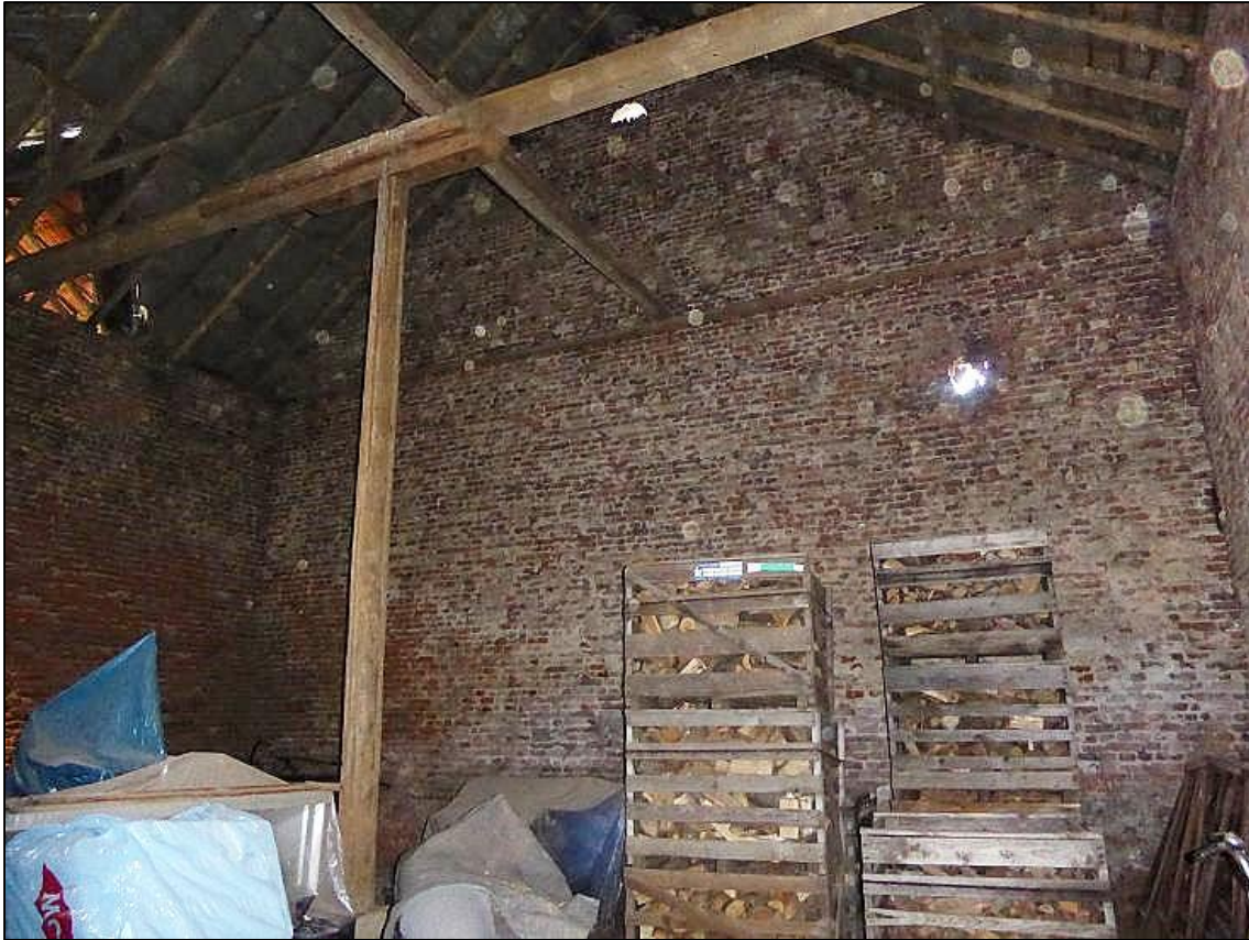
Abbildung 17: Große Scheune von innen. Das einfallende Licht zeigt Zugangsmöglichkeiten für Fledermäuse an.
