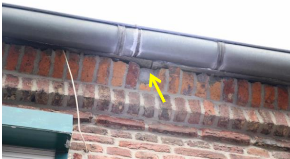
Foto 29: Für Fledermäuse nutzbare Zugänge in eines der Wohnhäuser.
