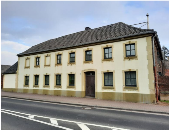
Foto 27: Wohnhaus Uerdinger Straße 105. Alle Wohnhäuser waren zum Zeitpunkt der Ortsbegehung im März 2021 noch bewohnt.
