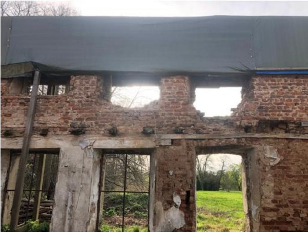
Auf der Ostseite sind Folienteile durchlöchert, durch Winddruck- und -sog perforiert. Die Folie liegt direkt auf dem Mauerwerk auf. Einige Stellen sind ohne Abdeckung.
