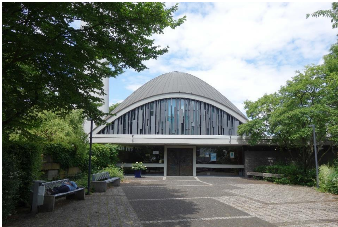
Meerbusch- Büderich, Ev. Christuskirche, Südfassade, Foto: Nadja Fröhlich (NF), LVR- ADR, 2022
