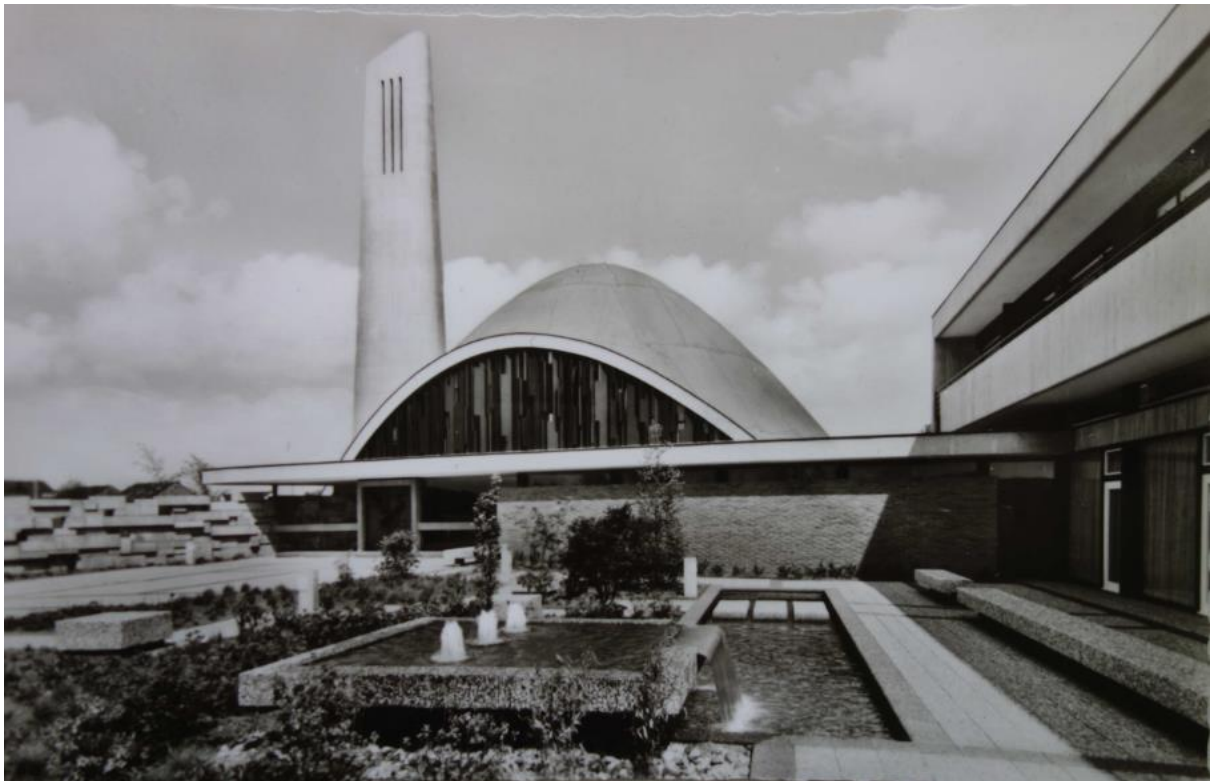
Meerbusch-Büderich, Karl-Arnold-Straße 12, ev. Christuskirche, Südseite mit Vorplatzgestaltung und bauzeitlichem Wassertisch, Wasserbecken und Waschbetonbänken, Repro einer historischen Postkarte aus dem Stadtarchiv Meerbusch.
