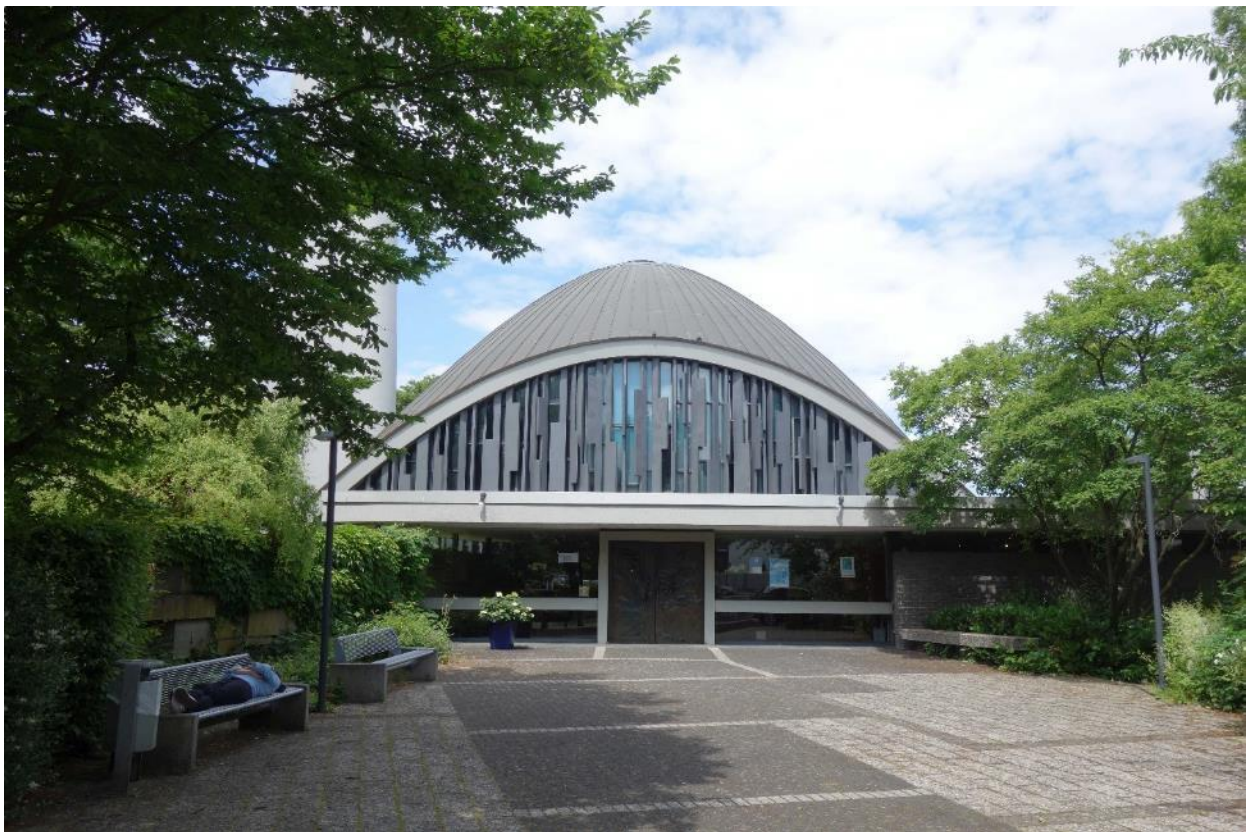
Meerbusch-Büderich, Karl-Arnold-Straße 12, Christuskirche, Südfassade, Foto: Nadja Fröhlich (NF), LVR-ADR, 2022.
