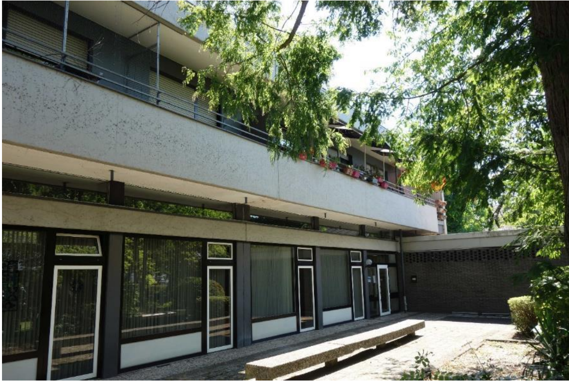
Meerbusch-Büderich, Karl-Arnold-Straße 12, Christuskirche, Westseite des Gemeindehauses, Foto: NF, LVR-ADR, 2022.
