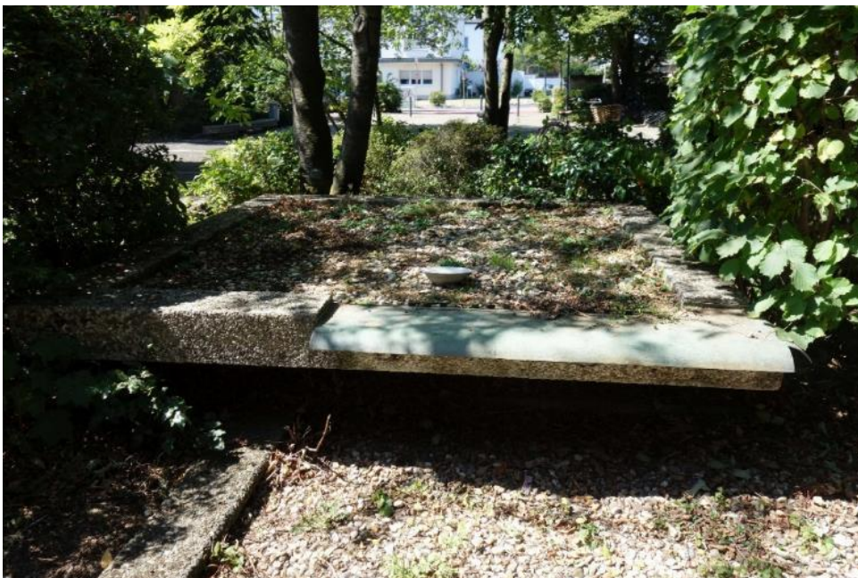
Meerbusch-Büderich, Karl-Arnold-Straße 12, ev. Christuskirche, Wassertisch und Wasserbecken, Foto: NF, LVR-ADR, 2022.
