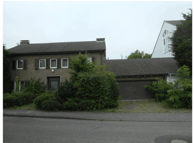
Ansicht von der Poststraße - Garage
