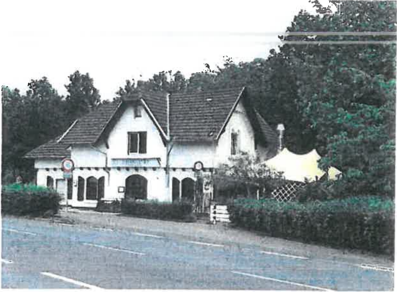
Ansicht Bestand von Moerser Straße / Süden
