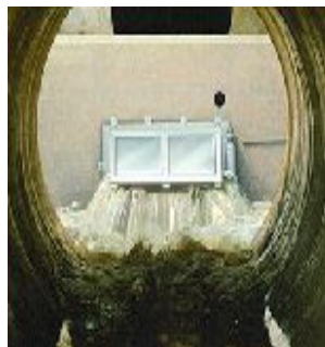
Abb. 22: automatische Schwallspülung für grosse Kanäle
