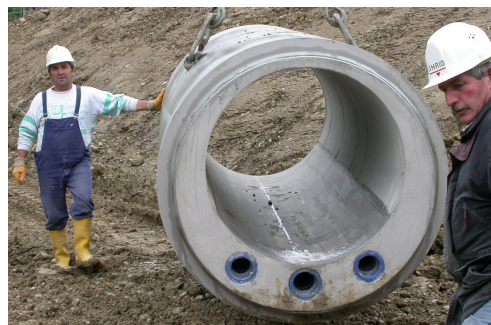
Abb. 21: Rinnenwärmetauscher als vorgefertigte Kanalisationselemente
