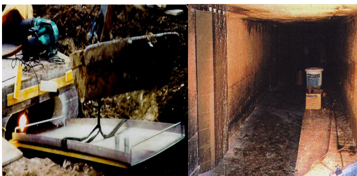
Abb. 17: Rinnenwärmetauscher für Kanäle mit Rechteckprofil Vor- und Rücklaufleitungen werden ausserhalb des Kanals geführt. Anschlüsse werden für die Verbesserung der Hydraulik mit Verschaltungen ausgekleidet. Vorteile: Der WT ist auch bei geringen Abflussmengen komplett überströmt, kein Querschnittsverlust. (eingesetzt in Zwingen)
