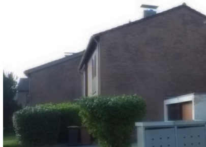
Typische Dachneigung mit Überstand traufständig zur Erschließung
