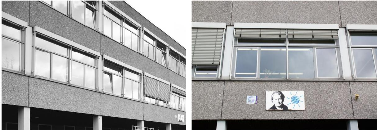
**Wir empfehlen daher einen Rückbau der alten Fassade und eine komplette Erneuerung der Ende der 1960`er Jahren erstellten Gebäudehülle; d.h. eine Erneuerung der massiven Fassadenelemente, der Fensteranlagen und der sanierungsbedürftigen Dachflächen.**
