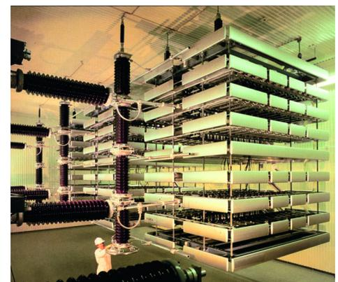
**Bild 2.** Die aktuell in der Konverterstation verwendeten wassergekühlten Thyristorventile (150 kV, 910 A). Pro Ventil sind 36 Thyristoren in Serie geschaltet
